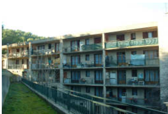
Vue du bâtiment B
